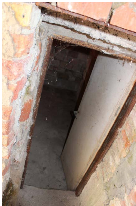
Sklep pod zahradou (černá přístavba)
