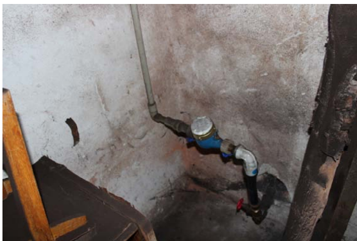
Vodoměr v kotelně, čerpadlo užitkové vody v prádelně
