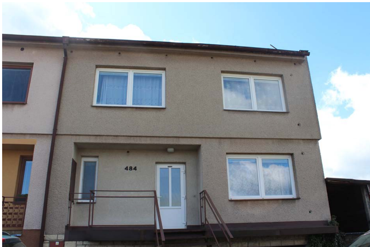
Severní pohled z ulice
