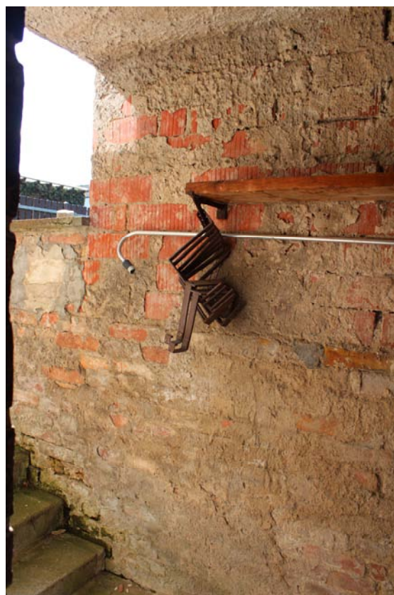
Schodiště z 1.PP na zahradu
